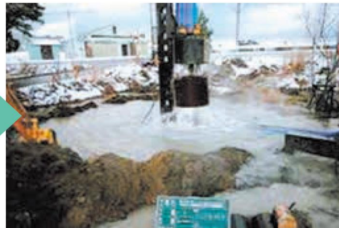
簡易水道等整備に向けた工事
