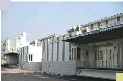
PFI方式で運営されている 浦安市千鳥学校給食センター (H20に輸入鶏肉を岩手県産鶏 肉とした偽装問題が起こった)
